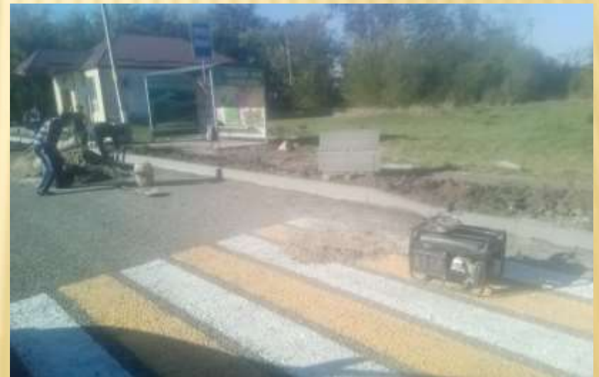
ремонт тротуара возле автобусной остановки в х. Чаплыгин
